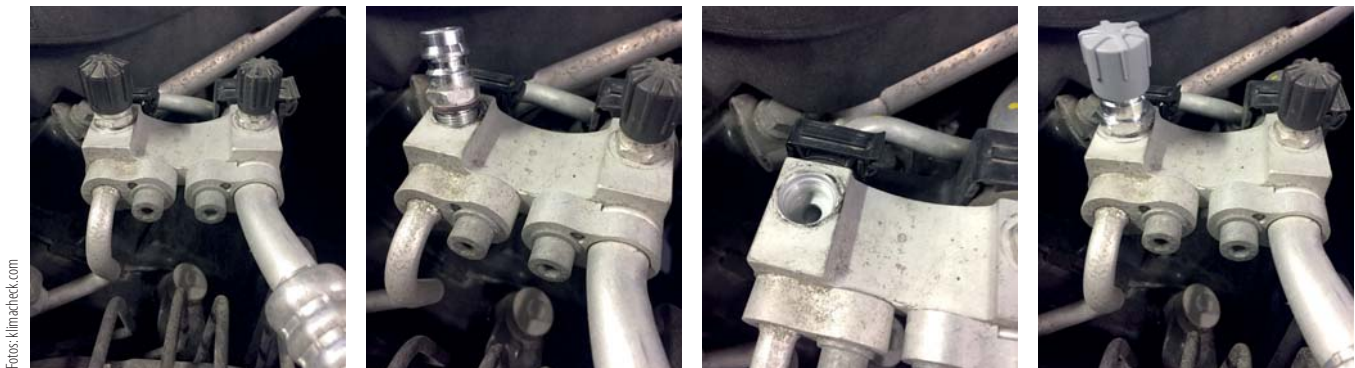
Ausgangszustand: die Serviceanschlüsse einer R134a-Klimaanlage.
