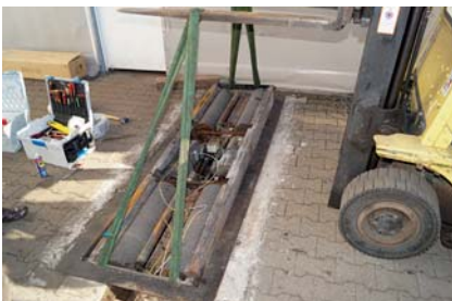
Der alte Bremsprüfstand wird mit dem Gabelstapler aus dem Fundament gehoben.
