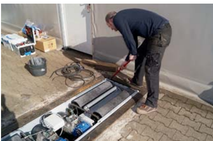
Mit einem Stemmeisen wird der neue Bremsprüfstand im Fundament ausgerichtet.
